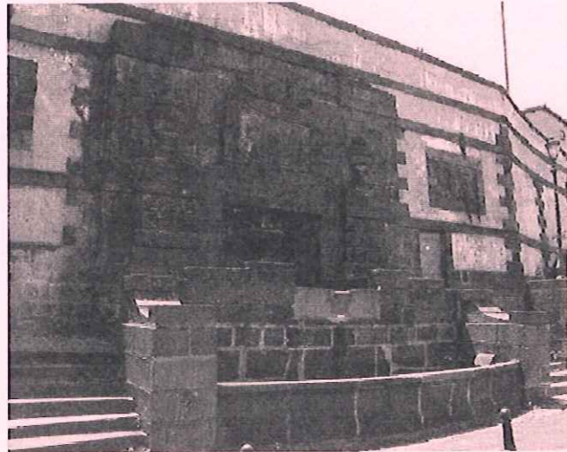
Vue d'ensemble de la fontaine
